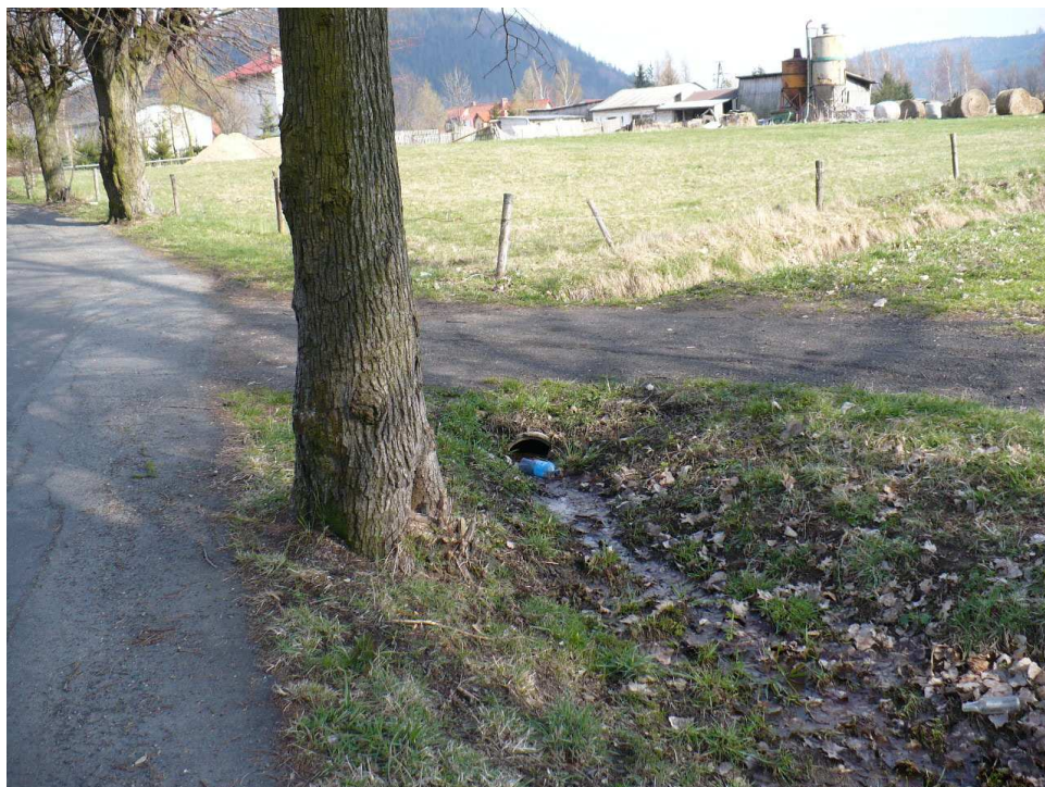
fot. 3 – zamulony przepust pod zjazdem do przebudowy
